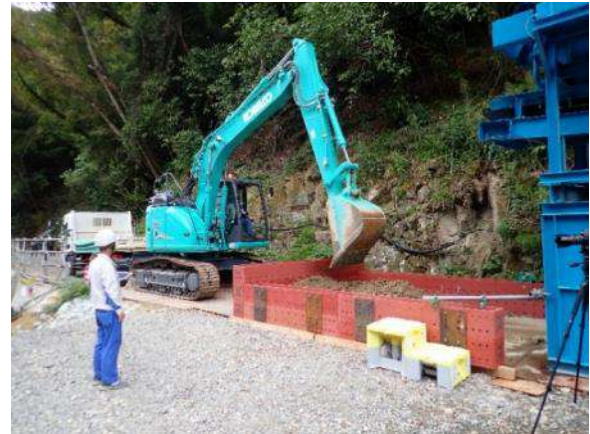
写真-5 ティーチングの状況
